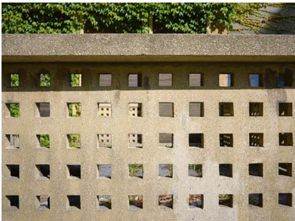
Obr. 50. Zikmundova vila, Zlín, Žlebová čp. 2894. Zábradlí terasy před restaurováním, po ošetření újtuže a po dokončení obnovy. (foto Petr Všečetka a Richard Trúchly, 2000–2014)
