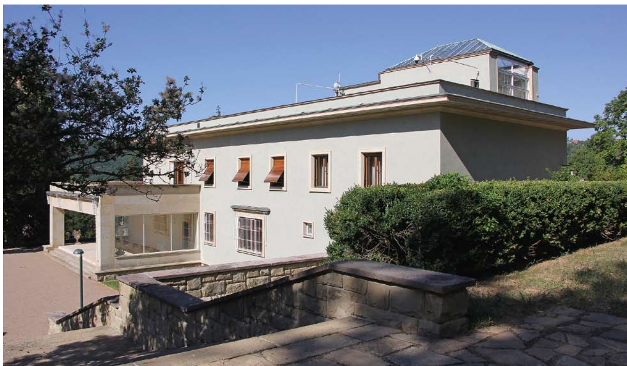
Obr. 16. Vila Stiassni, Brno, Hroznová 82/14. Východní fasáda po obnově – červenec 2015 (foto M. Solář)
