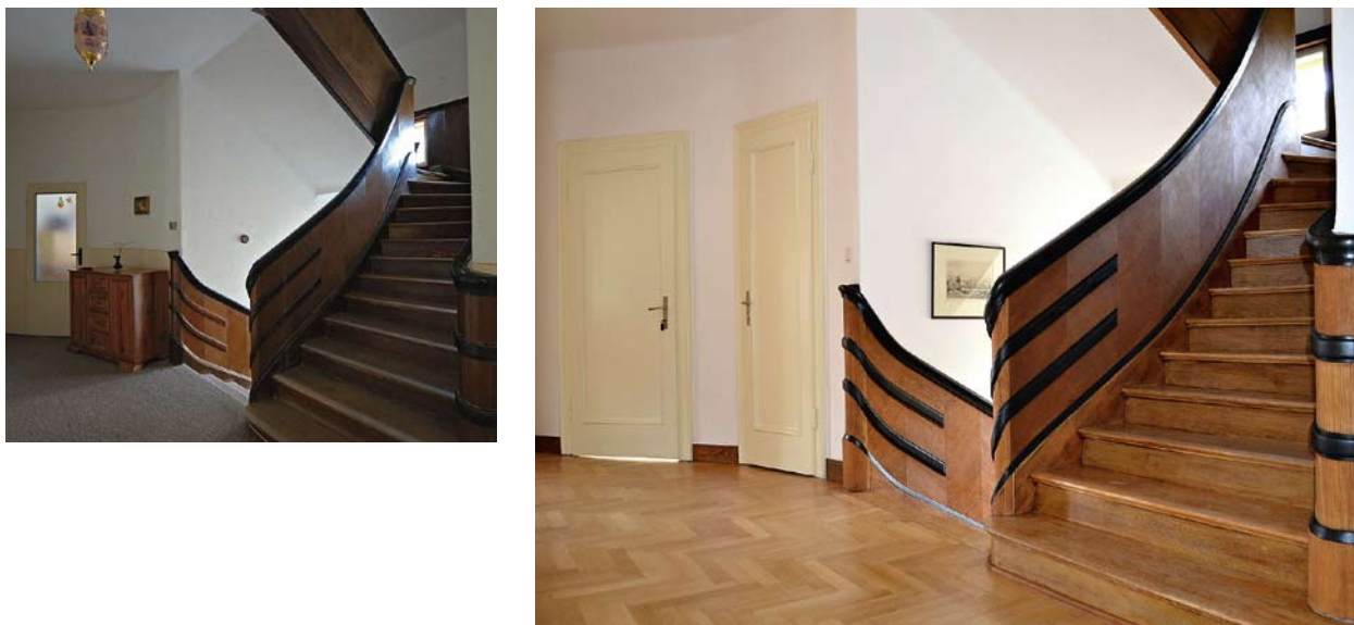
Obr. 31. Schneiderova vila, Jablonec nad Nisou, Zlatá 2912/9. Dynamicky modelované schodiště náleží k nejhodnotnějším prvkům v objektu. Byly z něj stejně jako z olýskových podlah odstraněny koberce, ručně očištěno jemným smirkovým papírem a natřeno lněným olejem. Na snímcích je patrný návrat k původním dveřním výplněm a dispozičnímu řešení. (foto P. Freiwilg)
