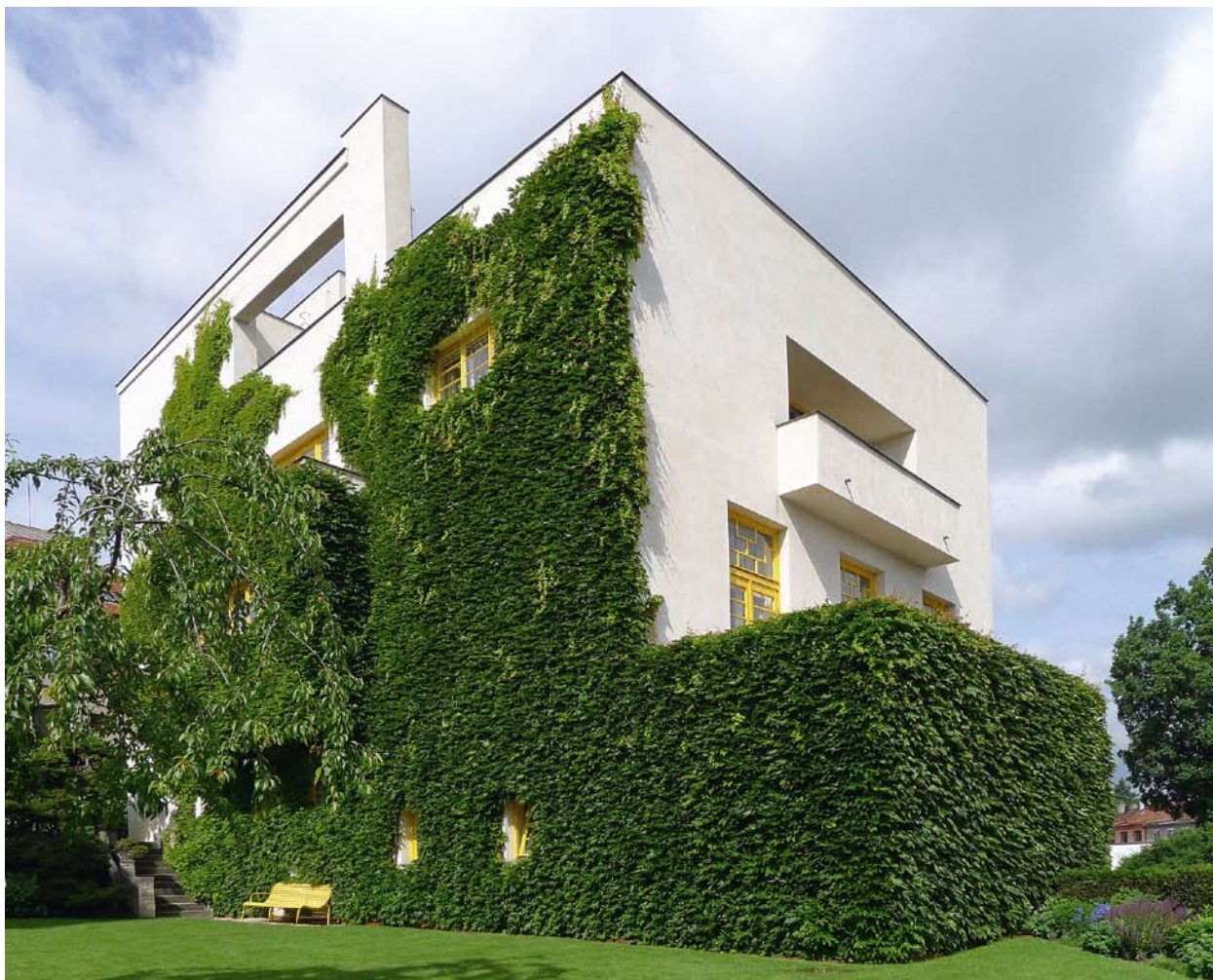
Obr. 60. Müllerova vila, Praha, Nad Hradním vodojemem 642/14. Pohled ze zahrady na východní a severní fasádu. (foto Miloš Solář)
