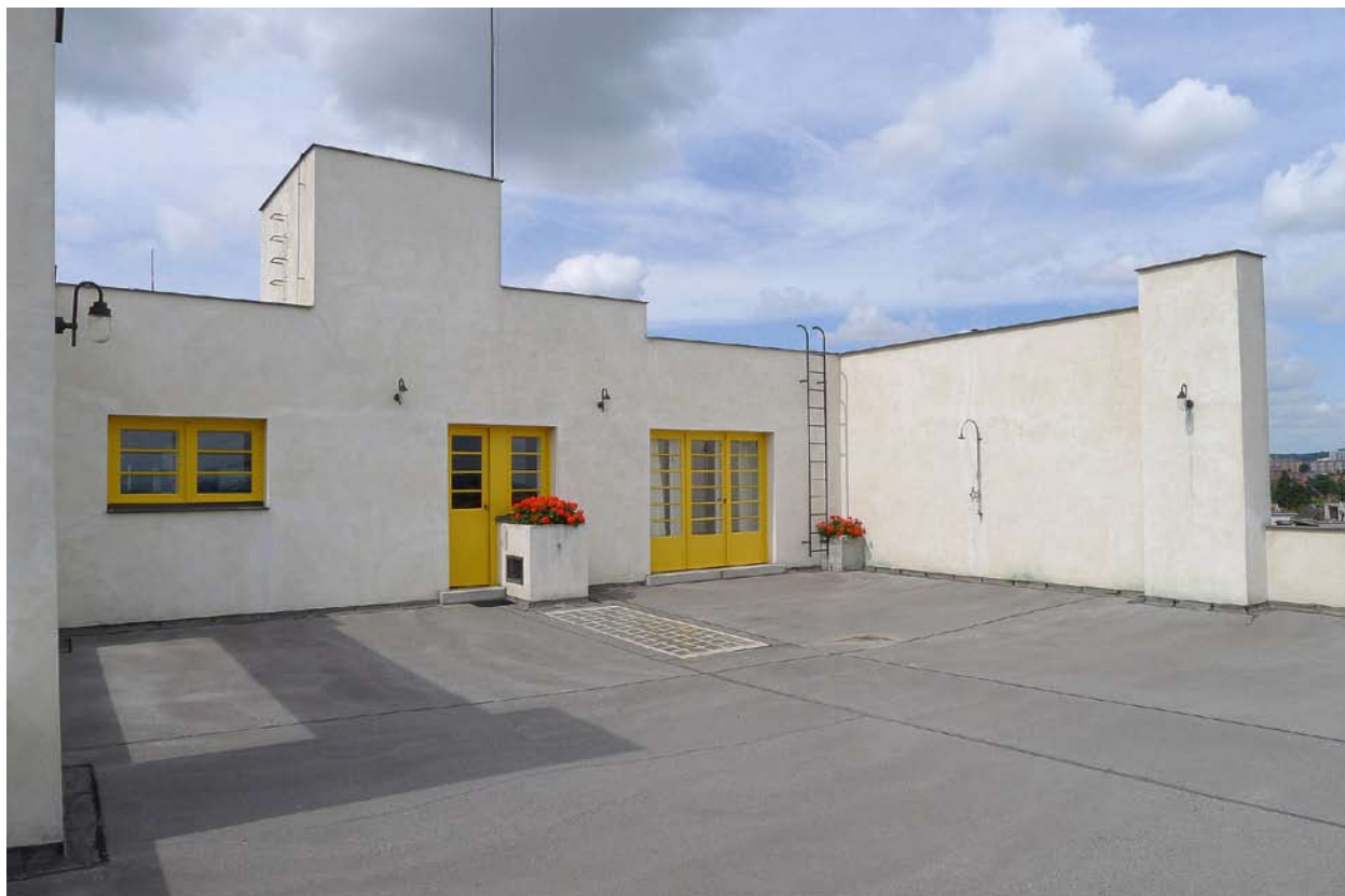
Obr. 58. Müllerova vila, Praha, Nad Hradním vodojemem 642/14. Obytná terasa vybavená sprchou. (foto Miloš Solar)
