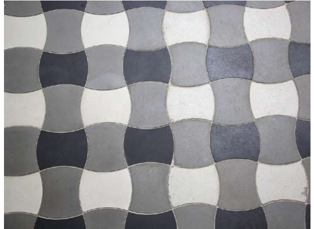
Obr. 18. Vila Stiassni, Brno, Hroznová 82/14. Podlaha přízemí služebního schodiště po obnově. Středem obrázku probíhá styk originální a doplňované dlažby – červenec 2015 (foto M. Solarř)
