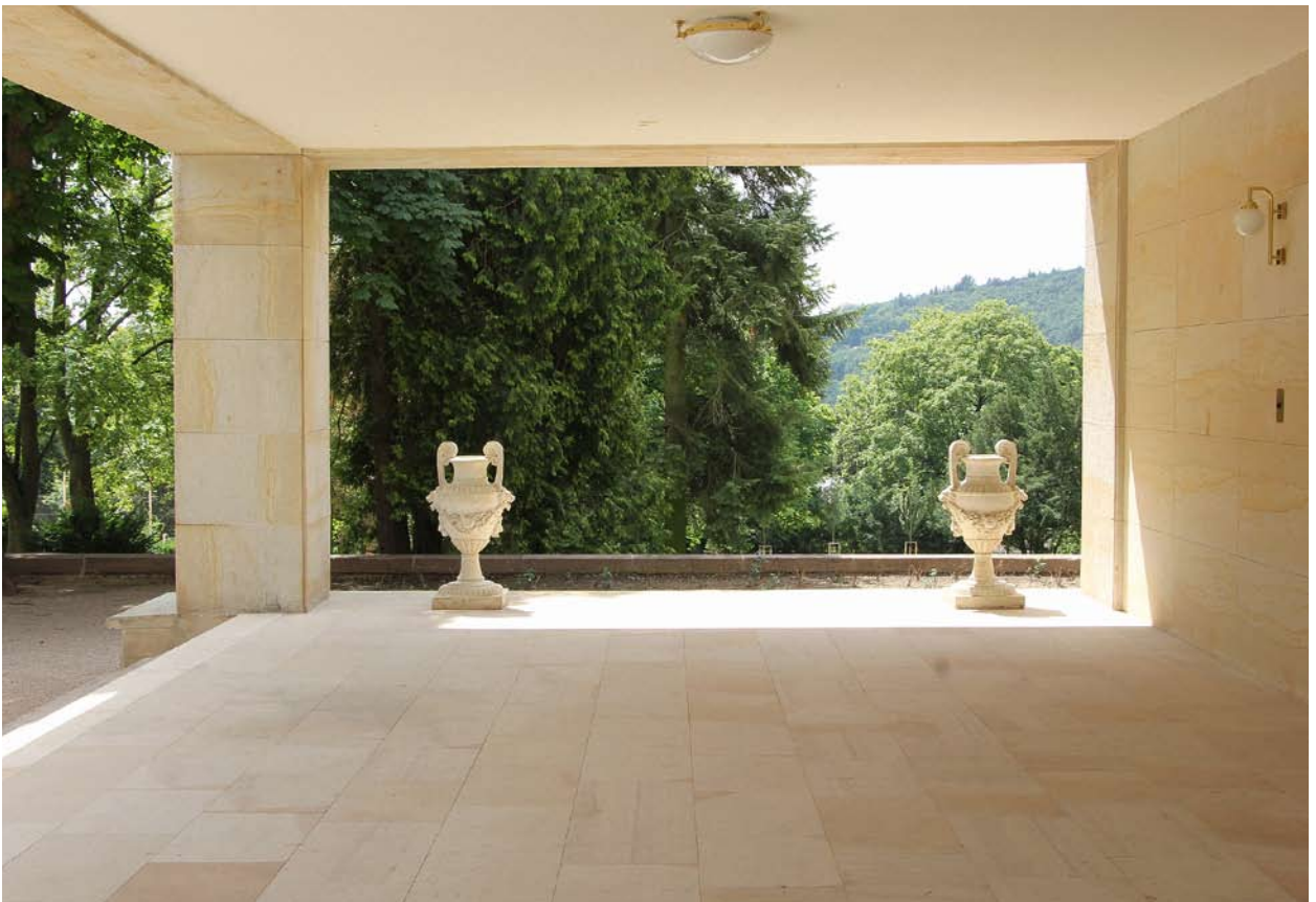
Obr. 19. Vila Stiassni, Brno, Hroznová 82/14. Lodžie po obnově, červenec 2015. (foto M. Solarř)
