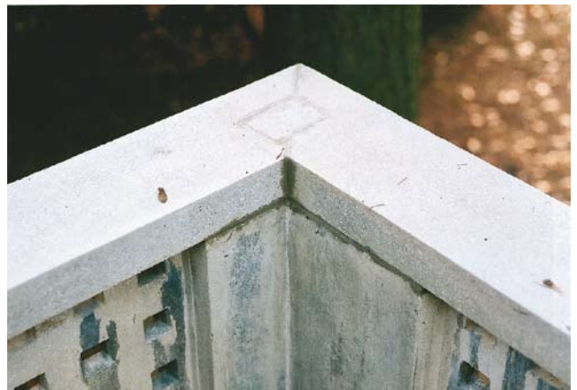
Obr. 50. Zikmundova vila, Zlín, Žlebová čp. 2894. Zábradlí terasy před restaurováním, po ošetření újtuže a po dokončení obnovy. (foto Petr Všečetka a Richard Trúchly, 2000–2014)
