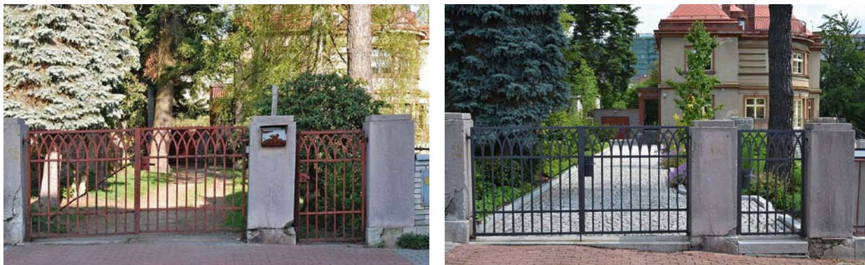
Obr. 25. Schneiderova vila, Jablonce nad Nisou, Zlatá 2912/9. Stav brány s brankou a příjezdové cesty před a po obnově. Oplocení je opatřeno kovovými špicemi, chybějící byly znovu skuty dle originálů. (foto P. Freiwillig)
