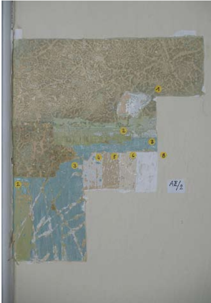
◁ Obr. 44. Malotova vila, Zlín, Lazy čp. 3689. Odkryto původních tapet v hlavní hale. (foto Zoja Matulíková, 2007)
