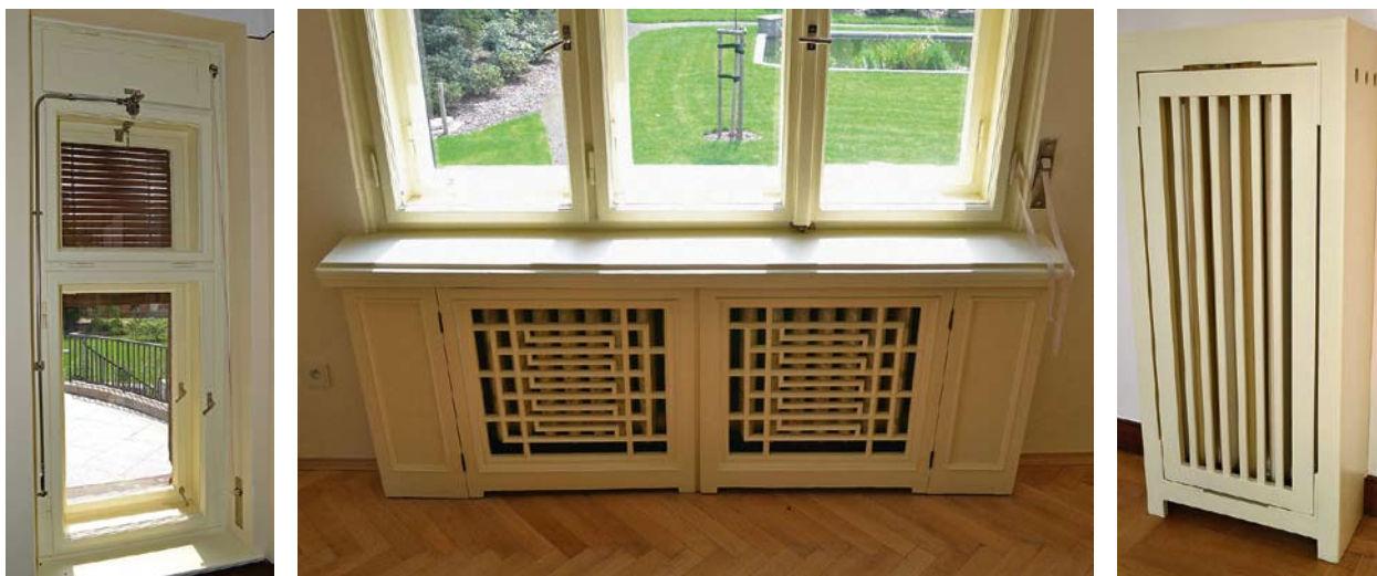
Obr. 32. Schneiderova vila, Jablonec nad Nisou, Zlatá 2912/9. Okno s původním ventilačním mechanismem s táhly a kováním z bílé mosazi a kryty radiátorů. Téměř všechny klíčky byly nákladně znovu odlity dle dochovaných originálů. Stav po obnově. (foto P. Freiwilg)
