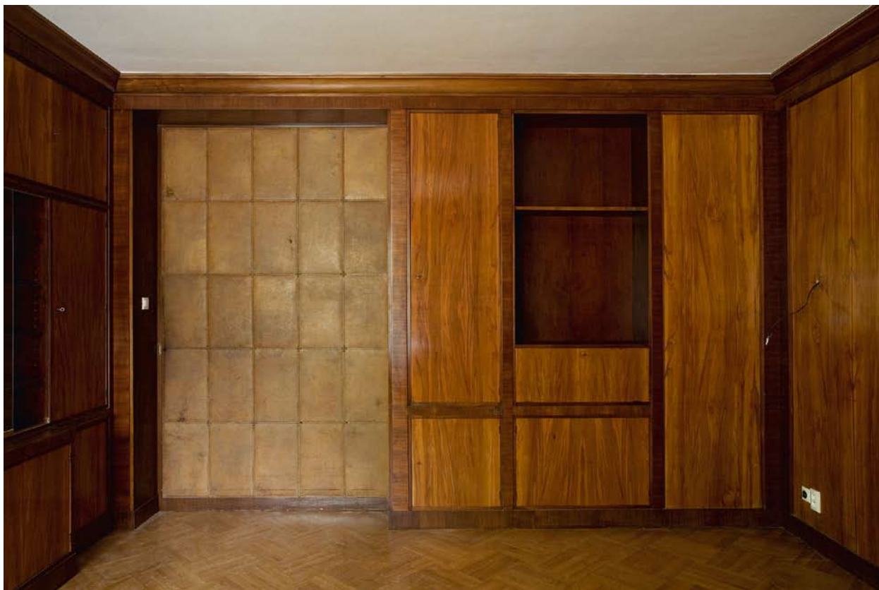
Obr. 42. Malotova vila, Zlín, Lažy čp. 3689. Restaurovaný interiér pracovny s konzervovaným koženým polstrovaním posuvných dveří do obývacího pokoje. (foto Toast images, 2007)
