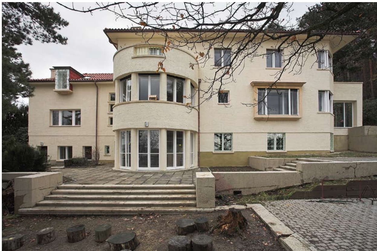
Obr. 33. Malotova vila, Zlín, Lazy čp. 3689. Stav po obnově. (foto Toast images, 2007)
