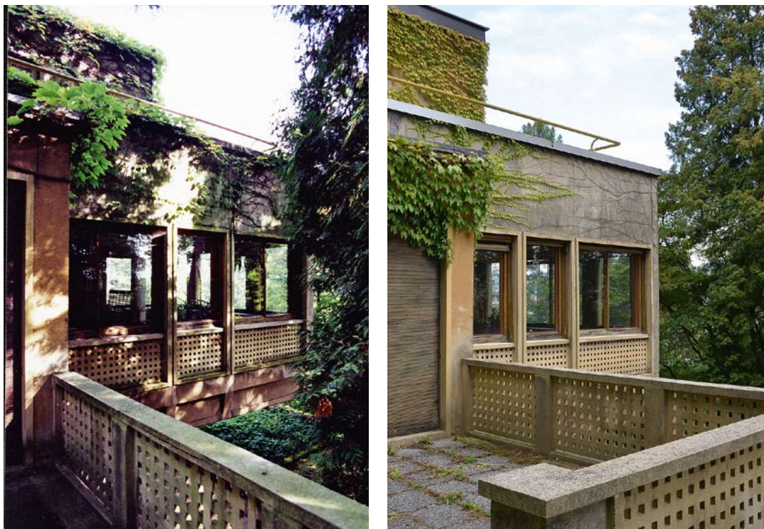
Obr. 48. Zikmundova vila, Zlín, Žlebová čp. 2894. Fasáda a zábradlí terasy před restaurováním a po jeho dokončení. (foto Petr Všecká, 2000–2014)
