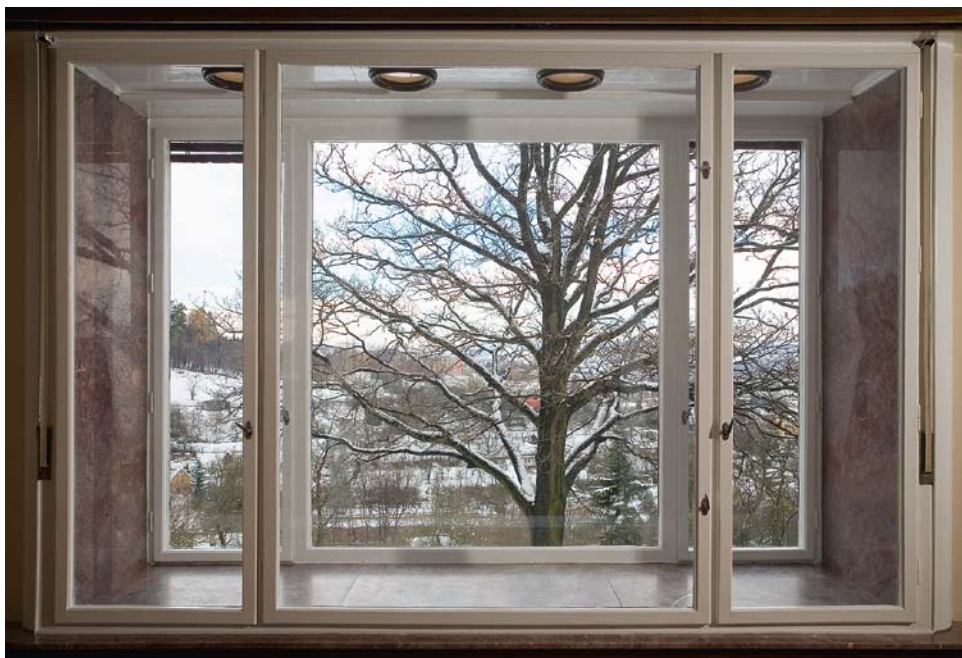
Obr. 40. Malotova vila, Zlín, Lazy čp. 3689. Repasované arkýřové okno obývacího pokoje s restaurovaným mramo- rovým obložním. (foto Toast images, 2007)
