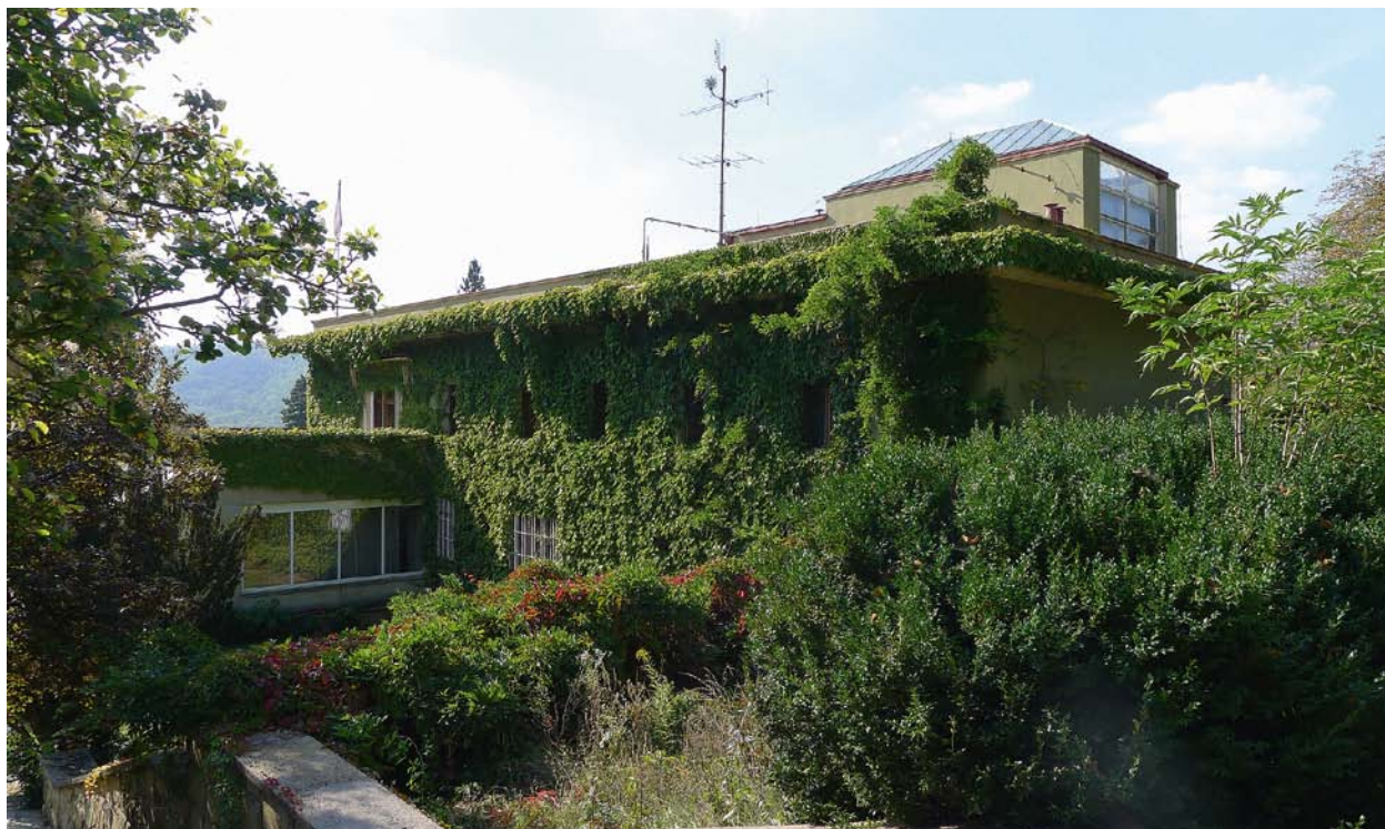
Obr. 15. Vila Stiassni, Brno, Hroznová 82/14. Východní fasáda před obnovou – říjen 2011 (foto M. Solář)
