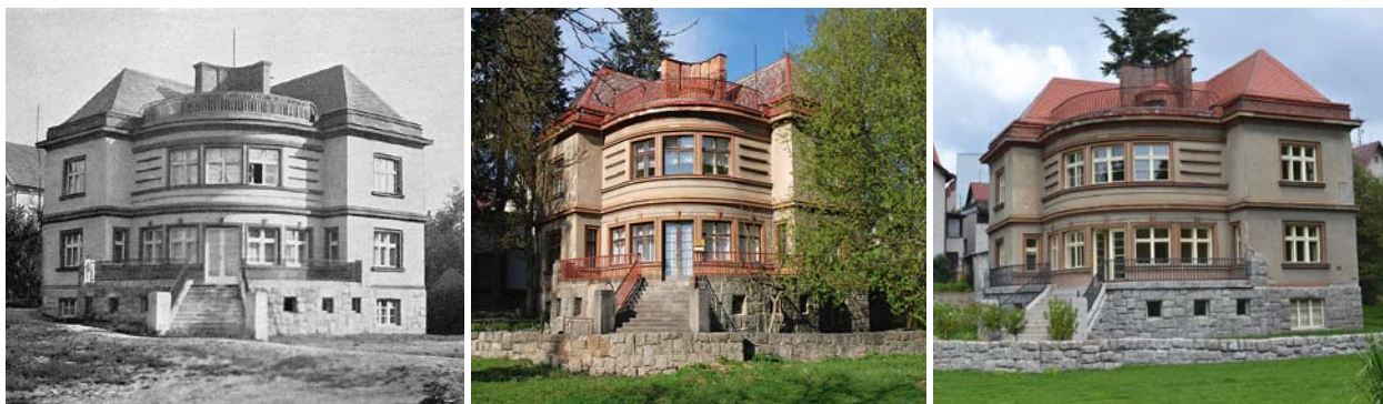
Obr. 22–24. Schneiderova vila, Jablonce nad Nisou, Zlatá 2912/9. Objekt po dokončení v roce 1930, před celkovou obnovou v roce 2009 a po ukončení její první etapy v roce 2014. (obr. 22 repro z: WOLF, Josef. Ingenieur architekt Rudolf Günter Gablonz a. N. München 1932; obr. 23 a 24 foto P. Freiwillig)
