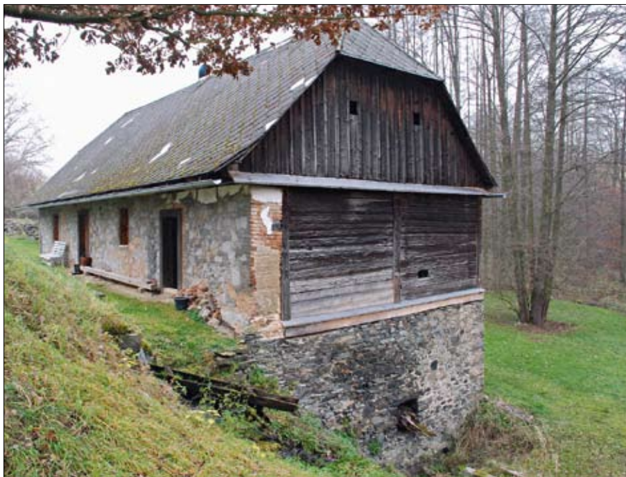
Obr. 6: Zahrádka – okres Plzeň-jih, mlýn č.e. 3 je příkladem stavby vytípané k památkové ochraně a následně prohlášené za nemovitou kulturní památku (foto J. Pešta, 2013).
