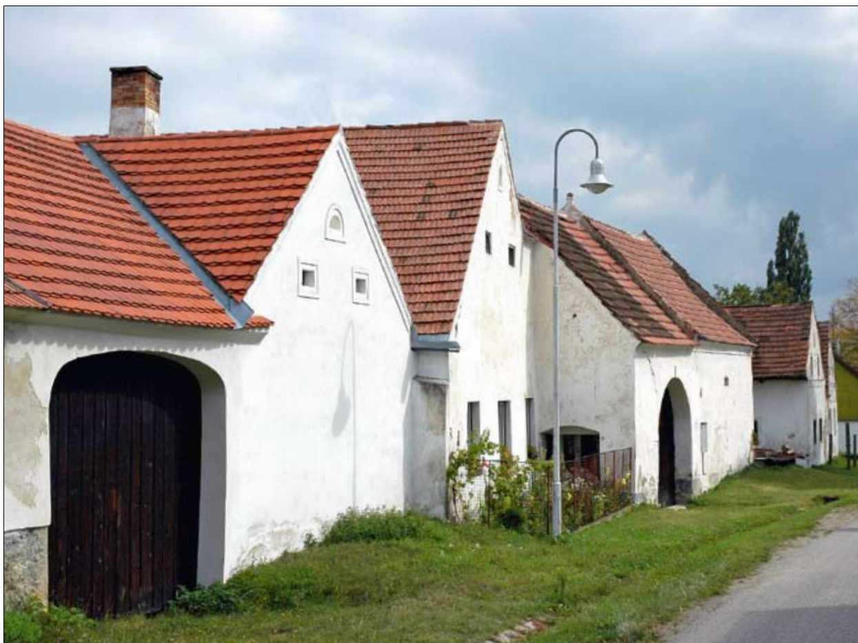
Obr. 51: Čertyně – okres České Budějovice, výrazově prostá zástavba náosi (foto J. Pešta, 2004).
