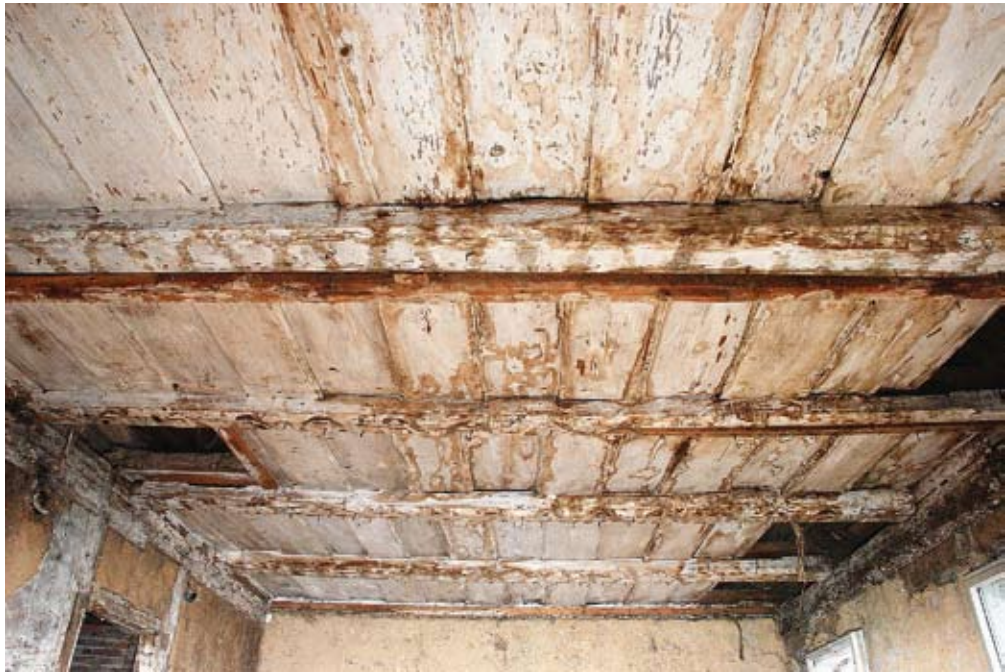
Dům čp. 424, záklopový strop místnosti v patře směrem do ulice (Buková – okres Děčín, foto J. Pešta, 2012).
