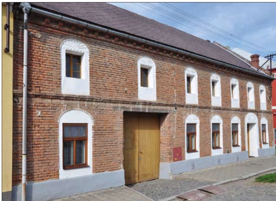
Obr. 88: Příkazy – okres Olomouc, dům čp. 24, vzorová fotografie objektu kategorie A (foto J. Pešta, 2012).
