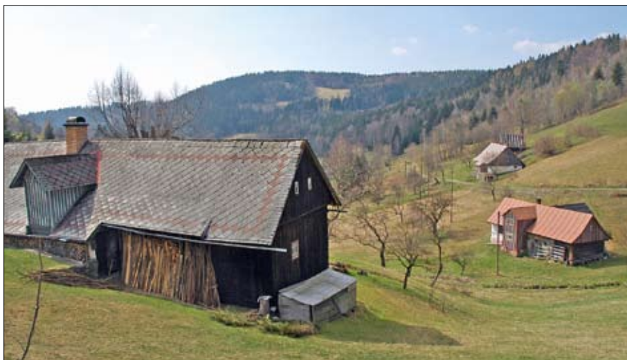
Obr. 96: Horní Dušnice – okres Semily, nenarušená zástavba v horní části vsi, ozorová fotografie sídla kategorie 1+ (foto J. Pešta, 2011).
