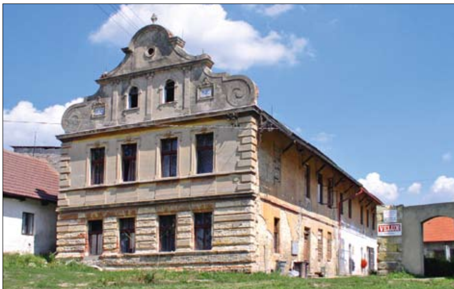
Obr. 41: Mutějovice – okres Rakovník, příklad velkého zděného domu s neorenesančním tvaroslovím (foto J. Pešta, 2003).
