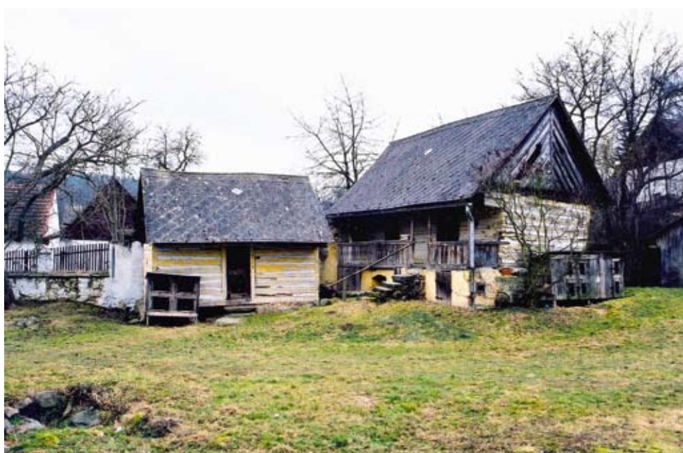
Roubené hospodářské stavby v jižním rohu dvora usedlosti čp. 1 (Zlámaná Lhota – okres Příbram, foto J. Pešta, 2001).
